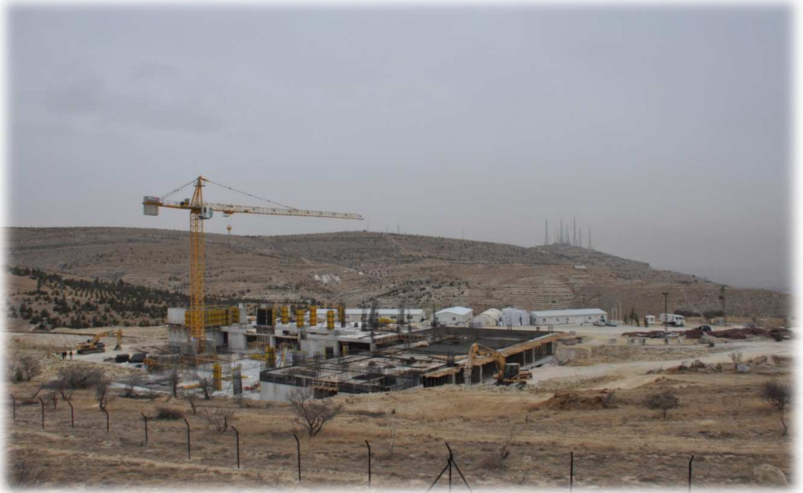
Resim-2: Mühendislik Mimarlık Fakültesi İnşaatı
