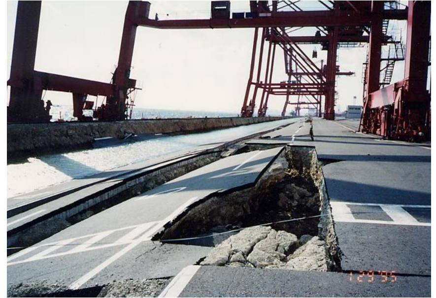
1995 Kobe depreminde iskele duvarı arkasında sıvılaşma nedeni hasar
