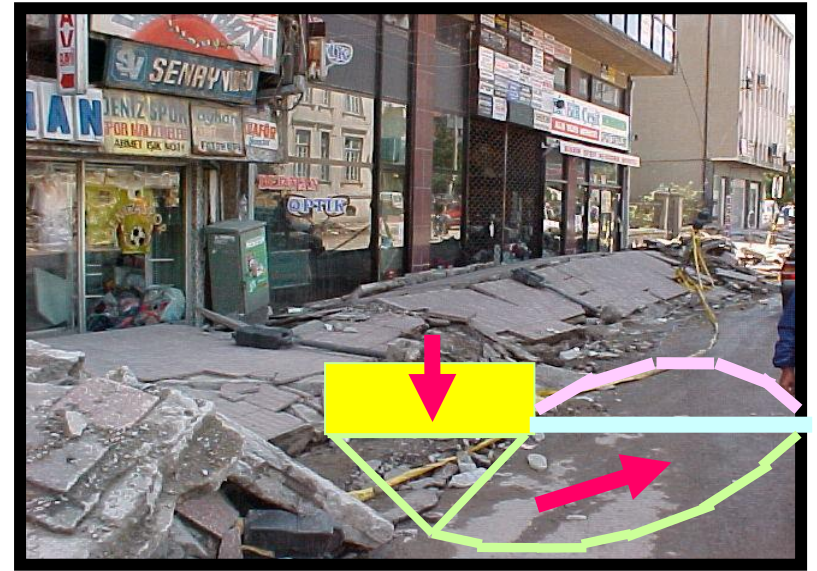
1995 Kobe depreminde iskele duvarı arkasında sıvılaşma nedeni hasar
